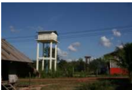
簡易水道の給水塔
